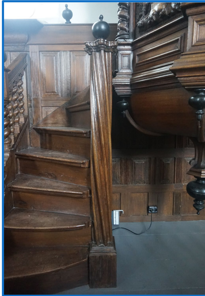
Figuur 38: De geschroefde trappaal van Kimswerd
